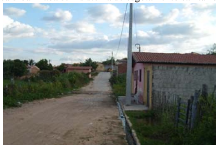
Fotografia 1 - Área urbanizada sem sistema de esgotamento sanitário na Baixa do CAIC
