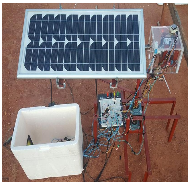
Figura 5 – Sistema fotovoltaico móvel.
